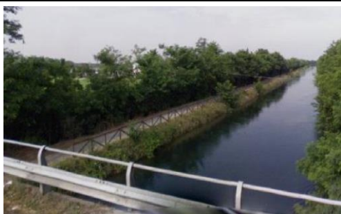
Canale Villoresi dal Ponte sulla SP
