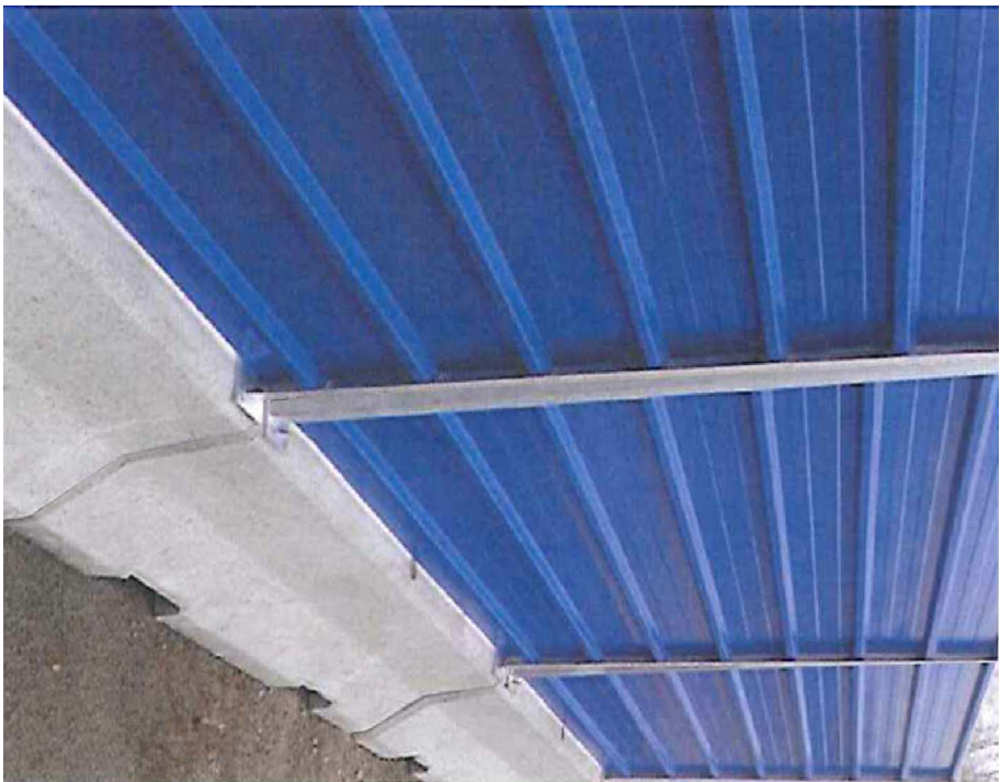
RECINZIONE IN NEW JERSEY tratto A-B
