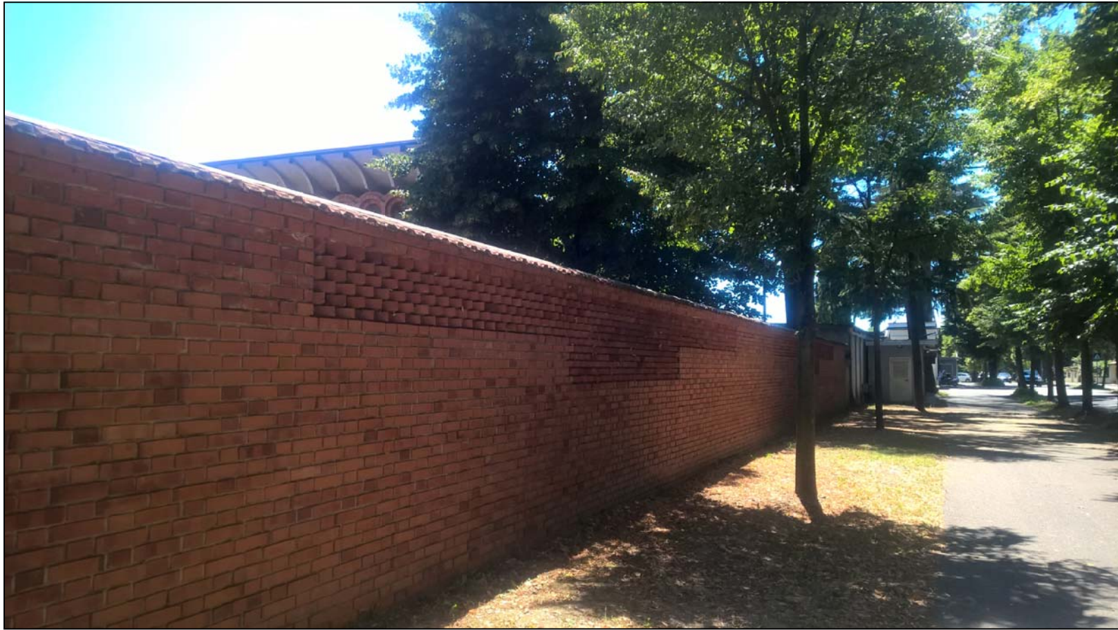
RECINZIONE ESISTENTE IN MURATURA
