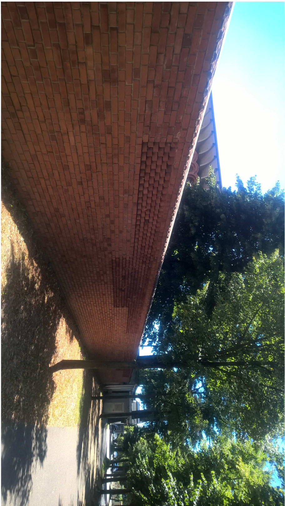
RECINZIONE ESISTENTE IN MURATURA
