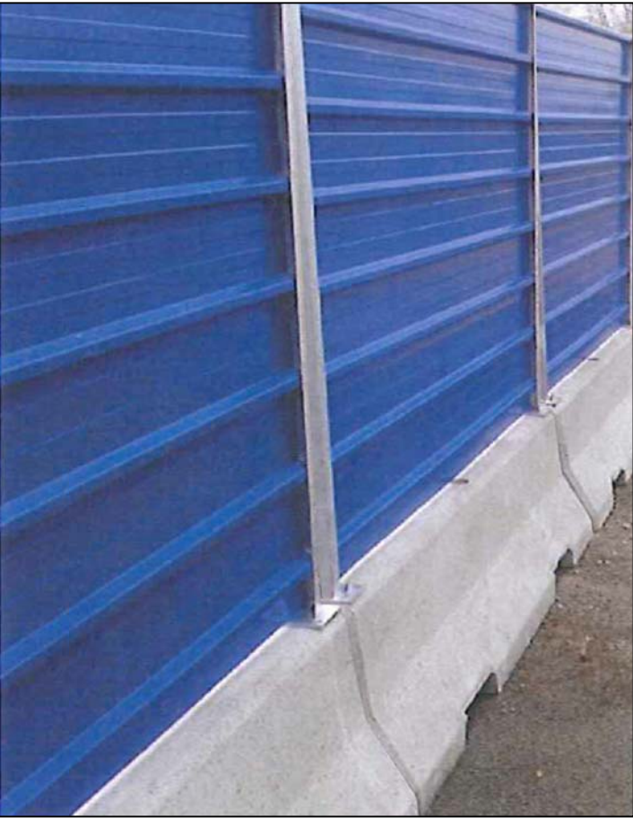
RECINZIONE IN NEW JERSEY tratto A-B
