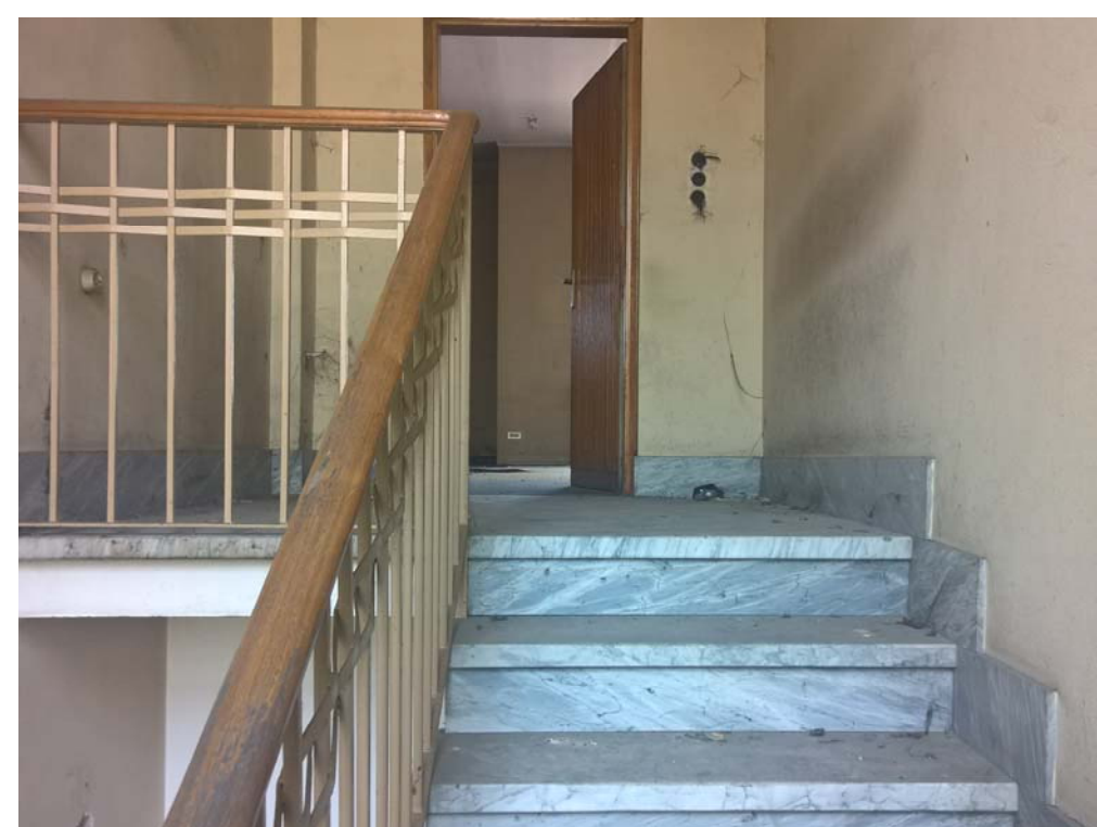
Vano scala esistente
