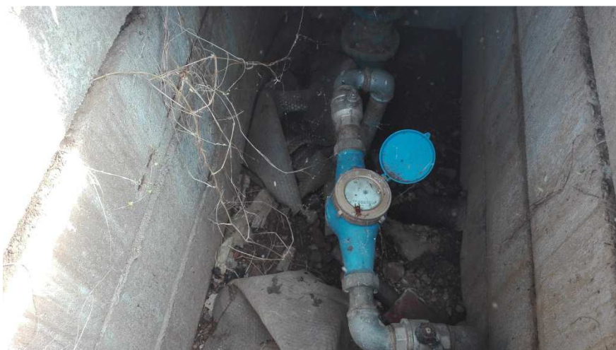
Pozzetto contatore acqua
