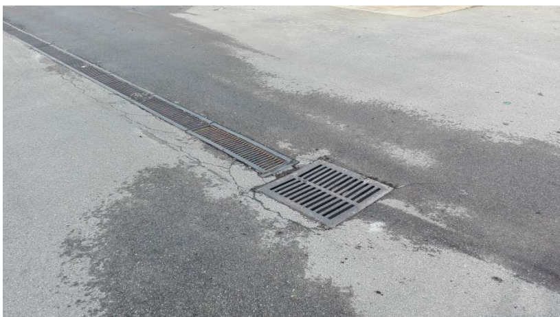
Rilievo dei pozzetti: pozzetto a valle della griglia
