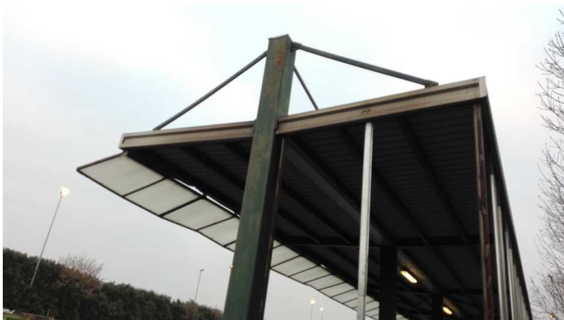
Particolare della tettoia esistente
