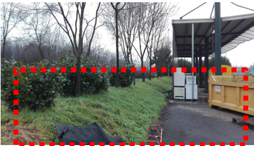
Vista della tettoia esistente. Sul retro l'area interessata dall'ampliamento a est
