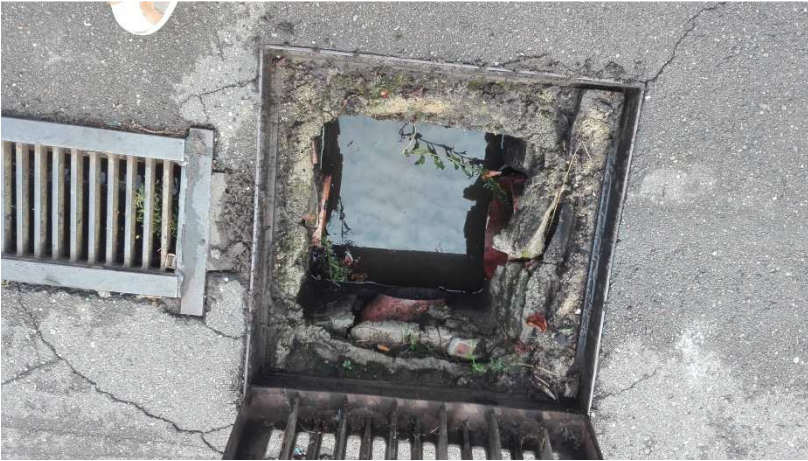
Pozzetto a valle della griglia
