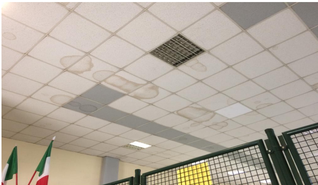
Bocciodromo veduta interna controsoffittatura
