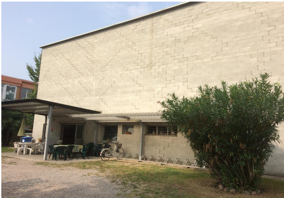
Bocciodromo veduta esterna, ingresso
