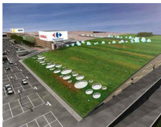
Tetto estensivo di Carregour a Carugate
