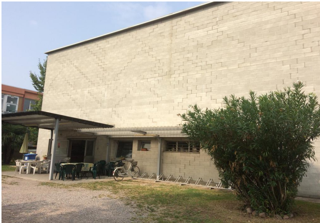
Bocciodromo veduta esterna, ingresso
