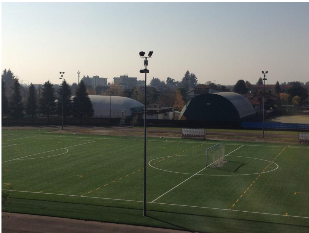
Il campo da calcio in erba sintetico e pali di illuminazione oggetti d'intervento.
