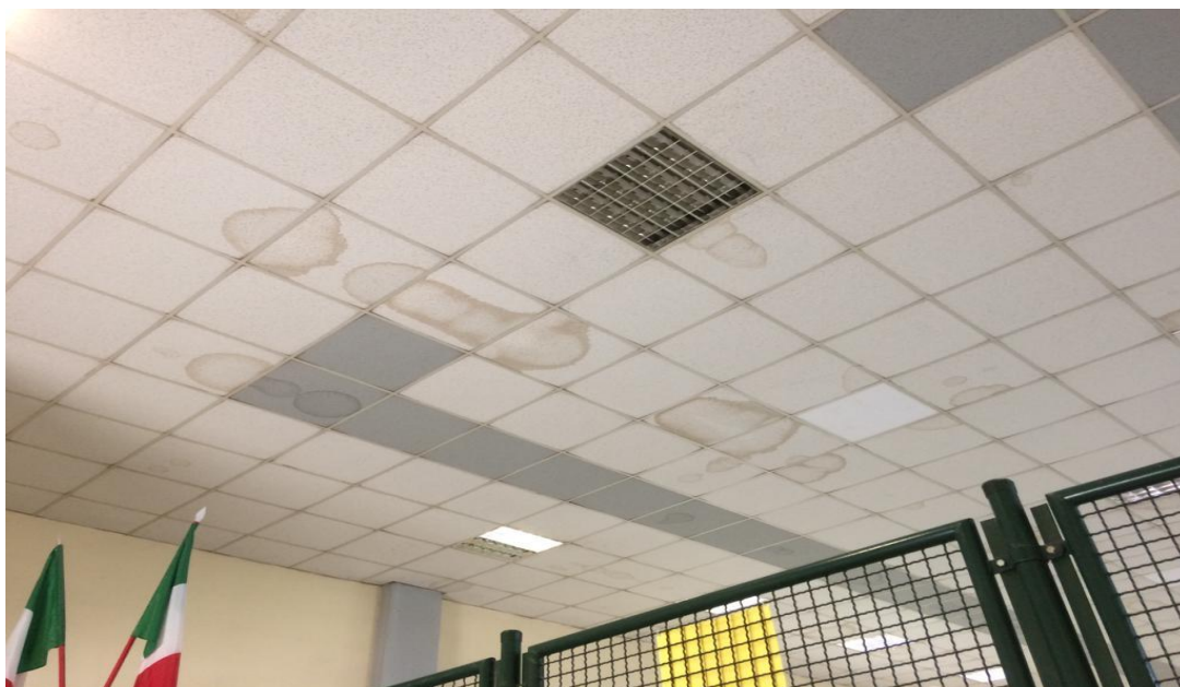
Bocciodromo veduta interna controsoffittatura
