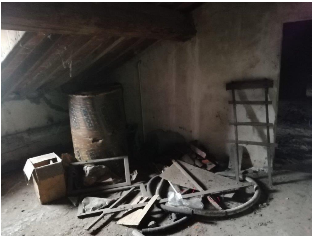
Materiale presente nel sottotetto e da rimuovere
