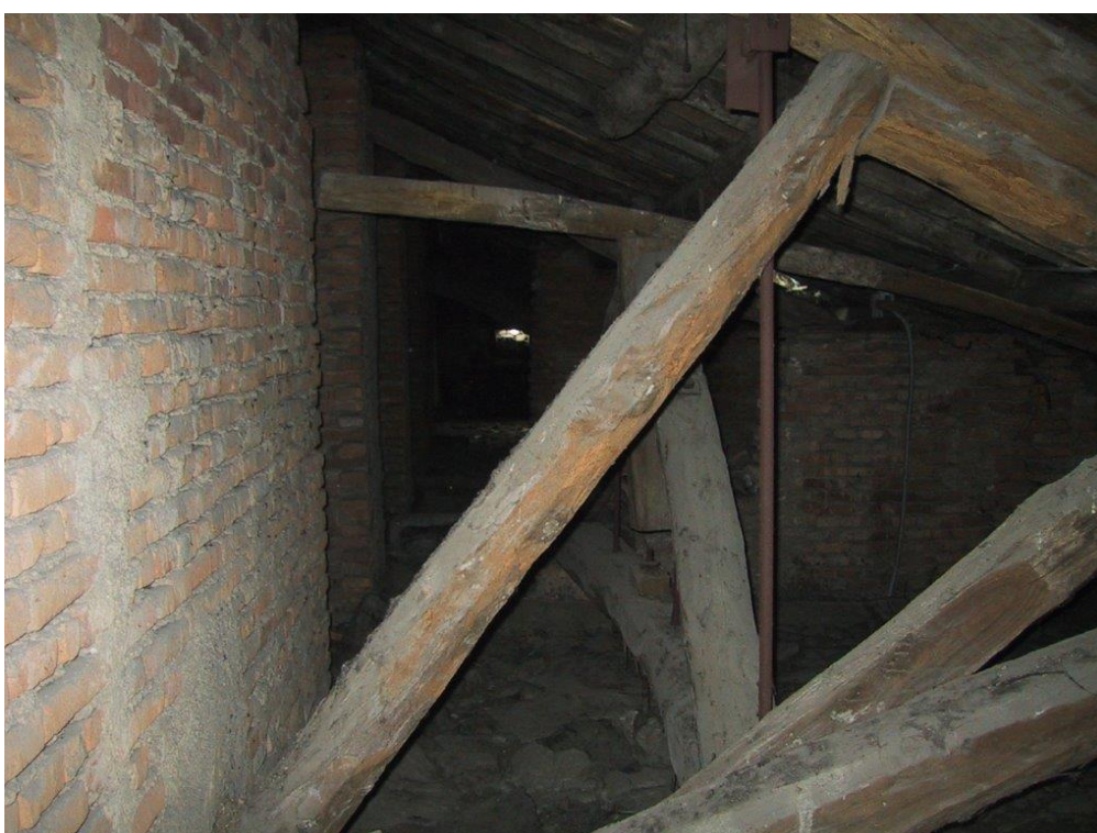
Tiranti al piano sottotetto di sostegno delle travi ed ammaro nelle strutture di copertura
