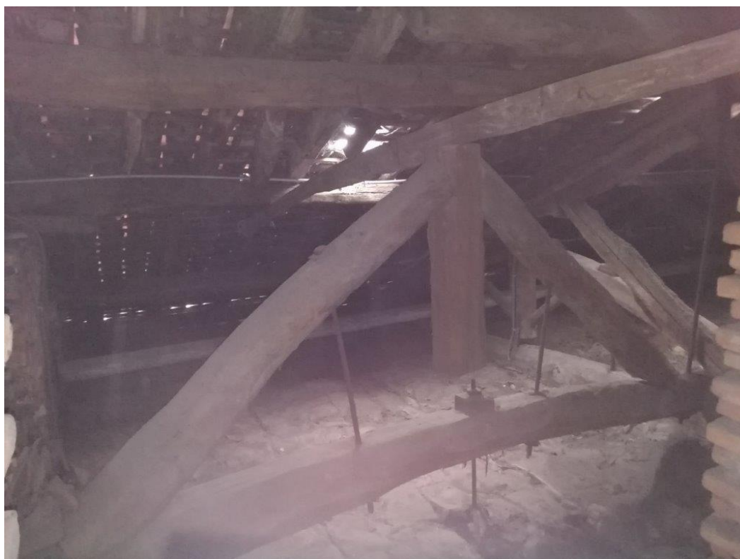
Capriatelle al sottotetto con appensione dei tiranti metallici delle travi
