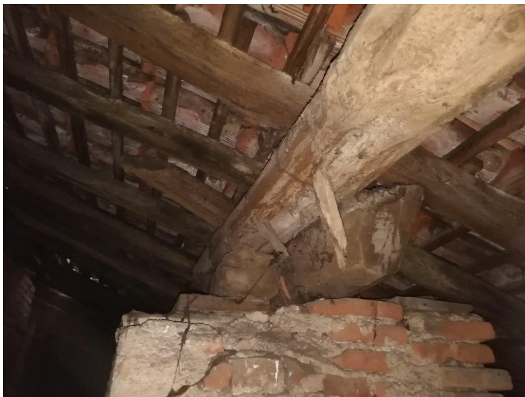
Particolari appoggi delle travi terzere rompitratta
