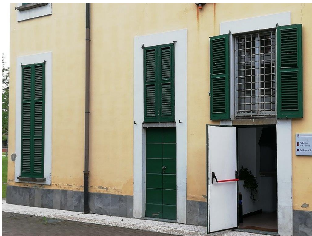
Particolare serramenti e gelosie e parti in pietra
