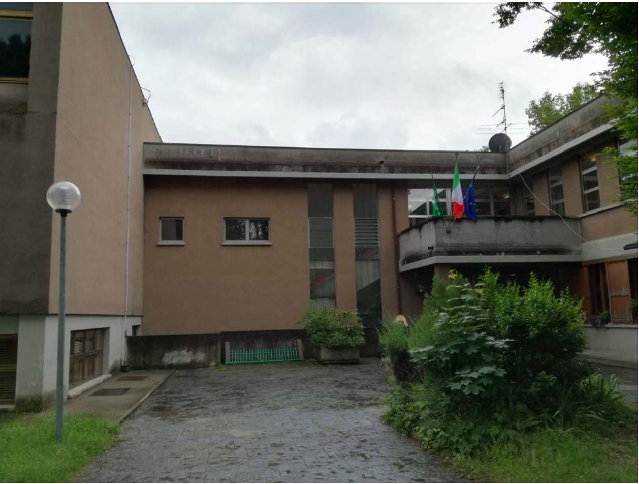
Ingresso scuola primaria
