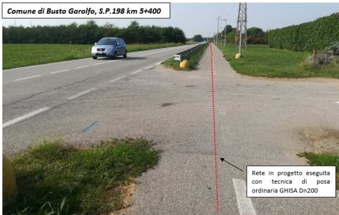
Tratto da posare con scavo a cielo libero su pista ciclabile in fregio alla S.P.198
