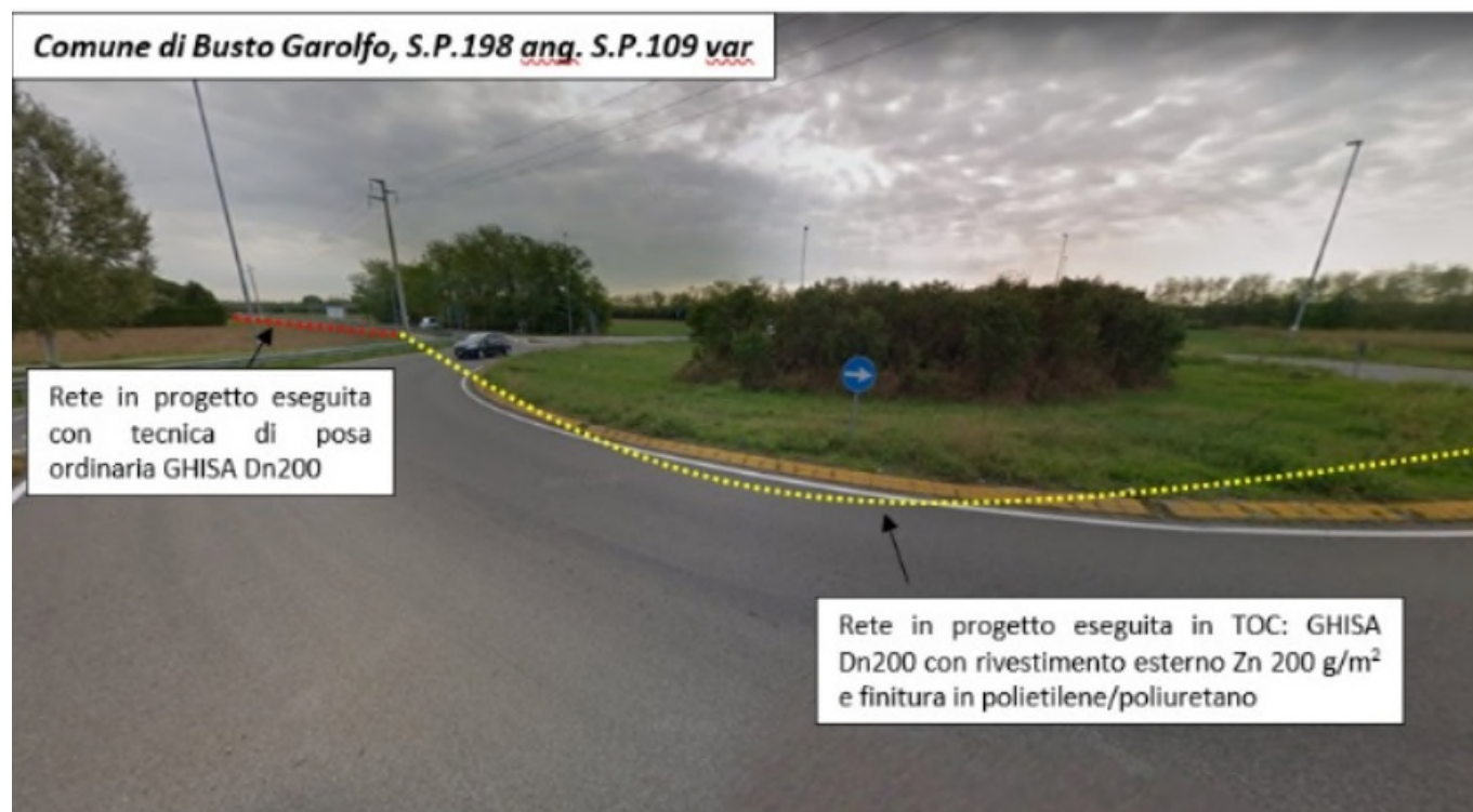
Figura 5.2 – Tratta da posare con TOC in S.P.198
