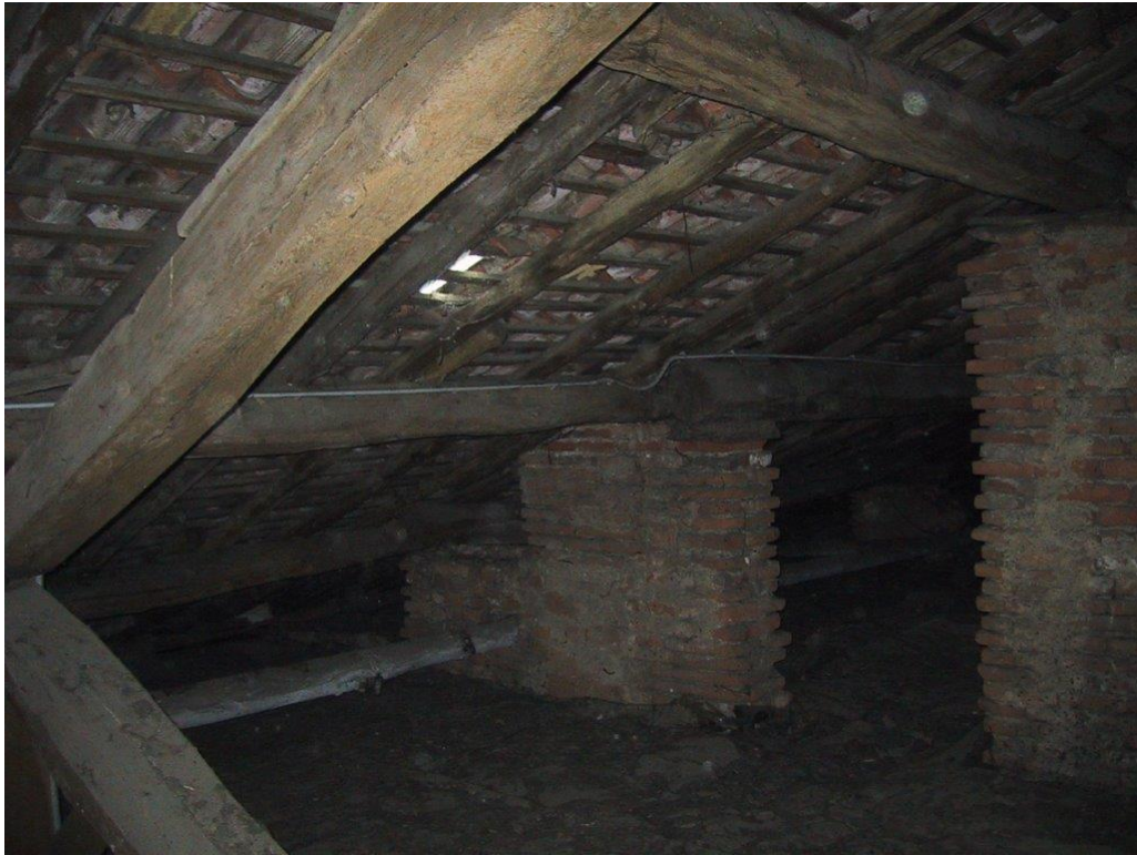
Strutture lignee esistenti ed ammalorate
