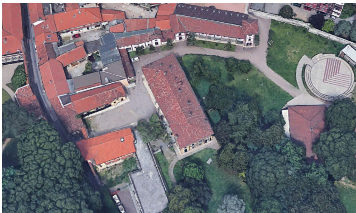
Vista ortofoto del complesso edilizio
