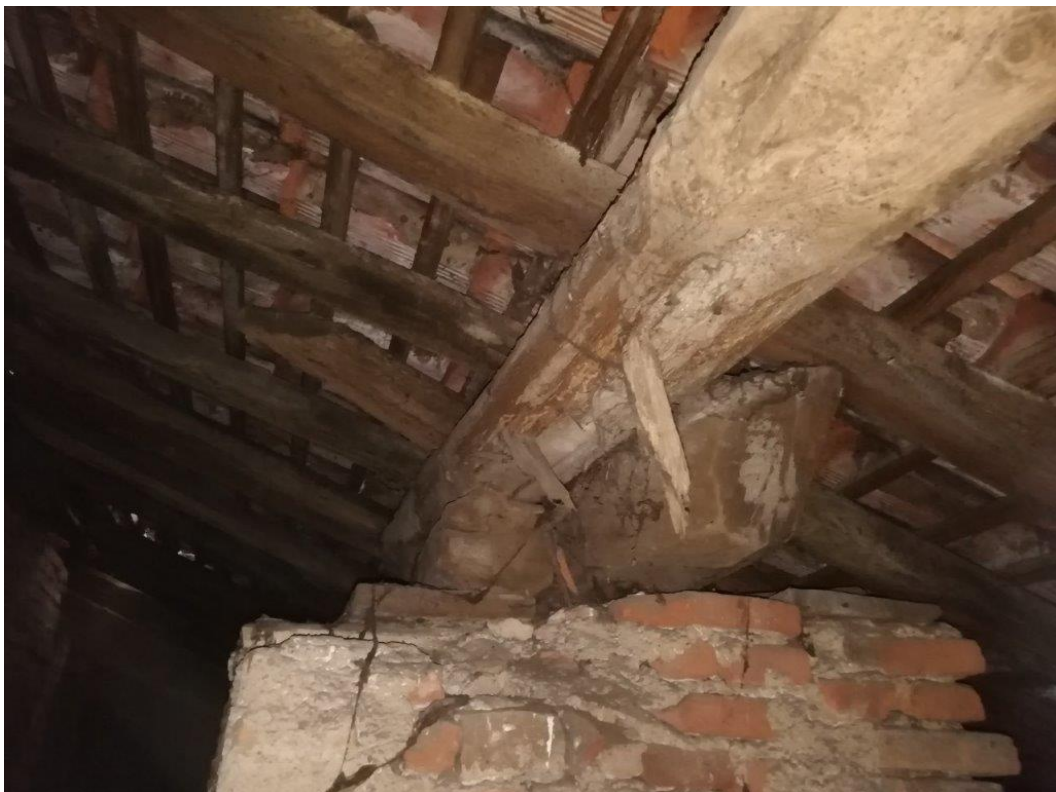
Particolari appoggi delle travi terzere rompitratta
