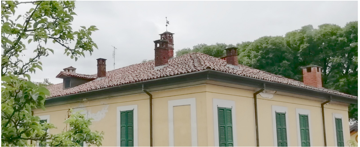
Attuale manto di copertura e torrini
