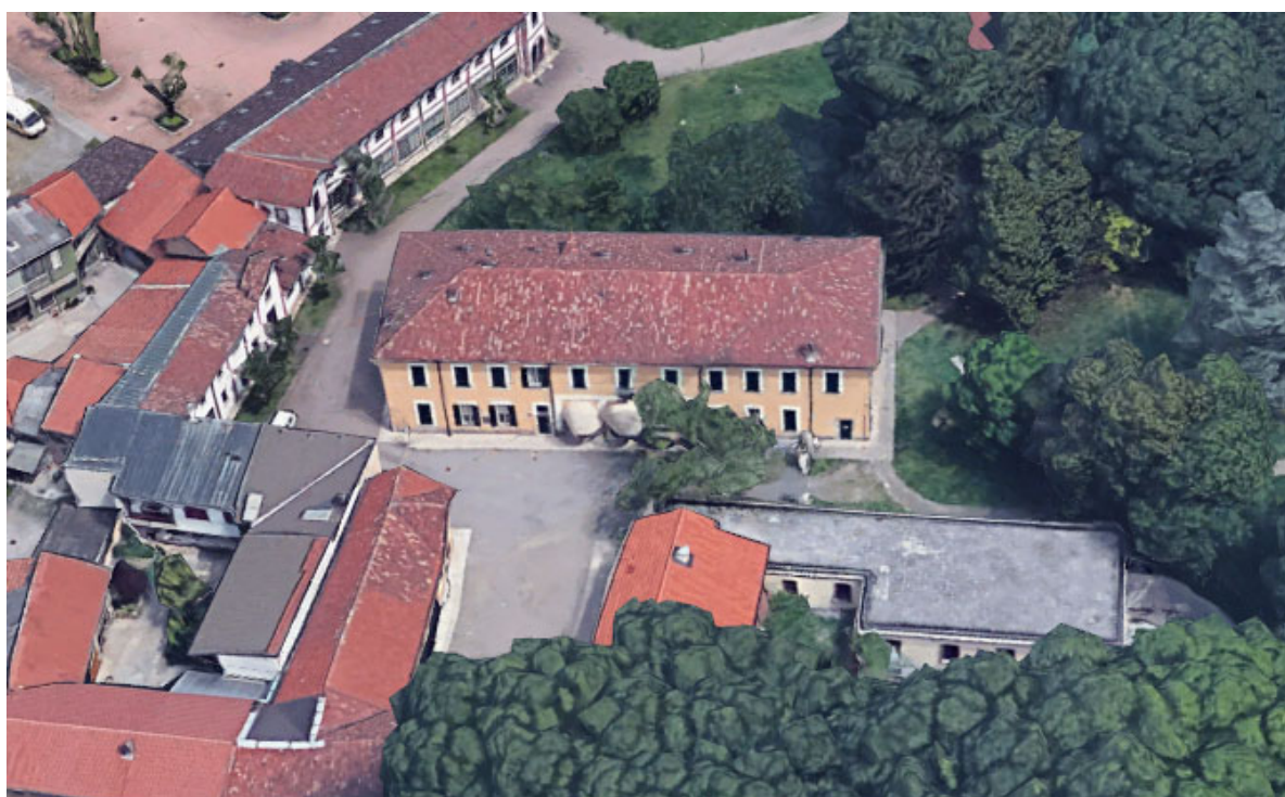
E del fabbricato “corpo A” attuale Biblioteca Comunale
