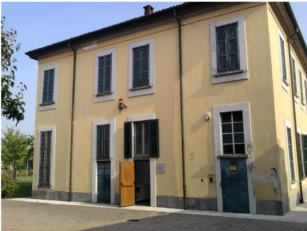
Prospetto nord-est dell'edificio
