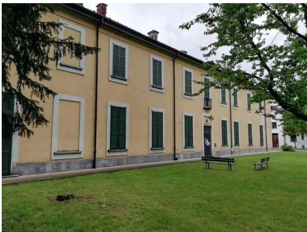
Prospetto nord – est dell'edificio
