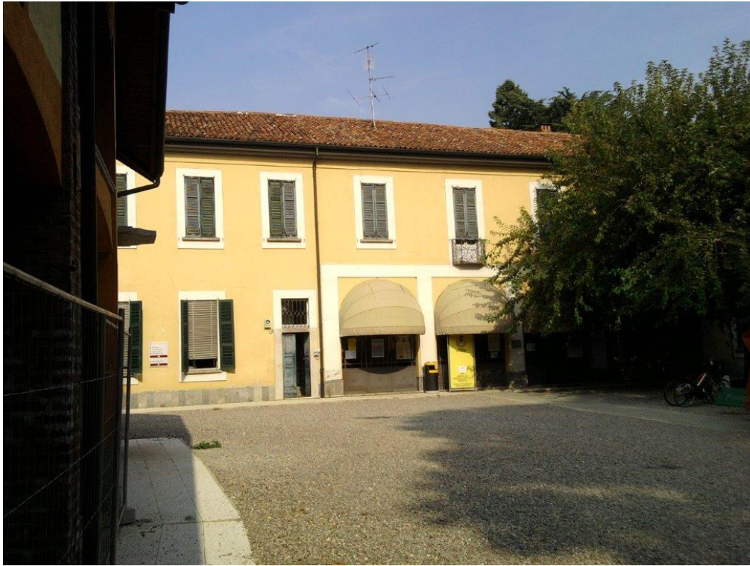
Prospetto nord-ovest dell'edificio
