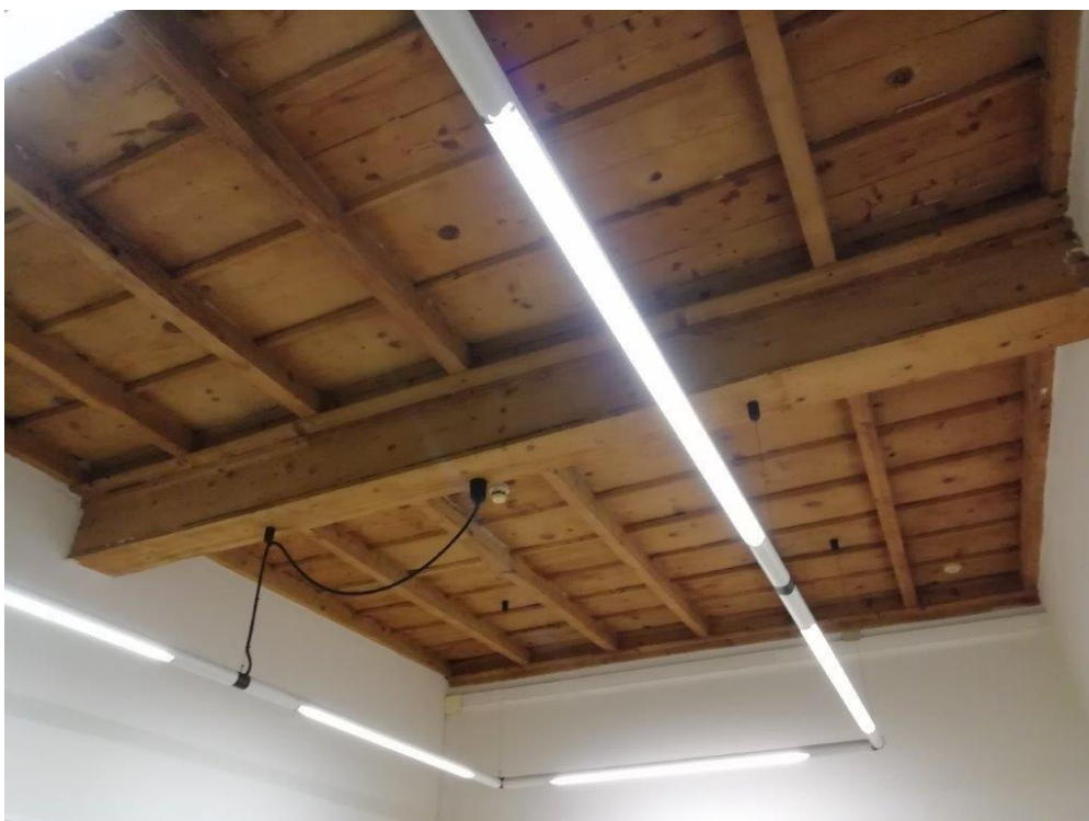
Travi lignee di copertura del primo piano con tiranti al piano sottotetto
