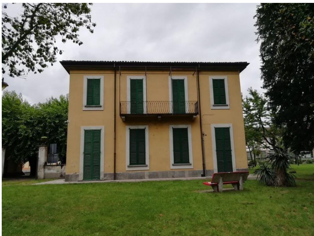
Prospetto sud- ovest dell'edificio
