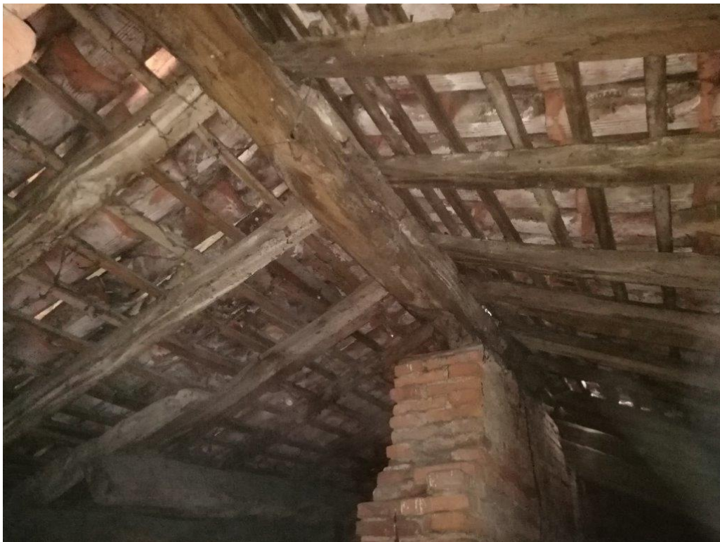
Strutture lignee esistenti ed ammalorate
