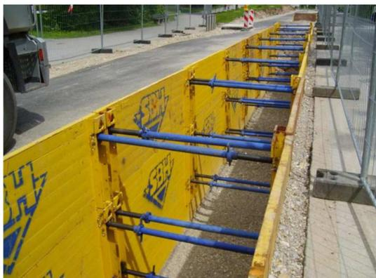
Di seguito si riporta il tipologico di avanzamento del cantiere in cui è possibile identificare la presenza delle barriere mobili di segnalazione dello scavo, come previsto dall'art. 118 comma 5 del D. Lgs. 81/08 e s.m.i. Le stesse saranno da predisporre anche in presenza di scavi inferiori ai 2,00 m di profondità al fine di prevenire la possibile caduta di un operatore all'interno dello stesso.
