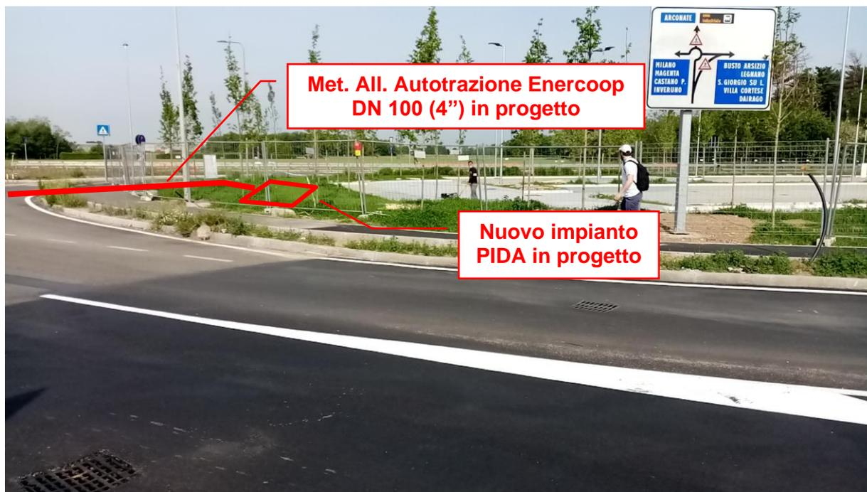
**Foto 11: Attraversamento Via Arconate e nuovo impianto tipo PIDA**
