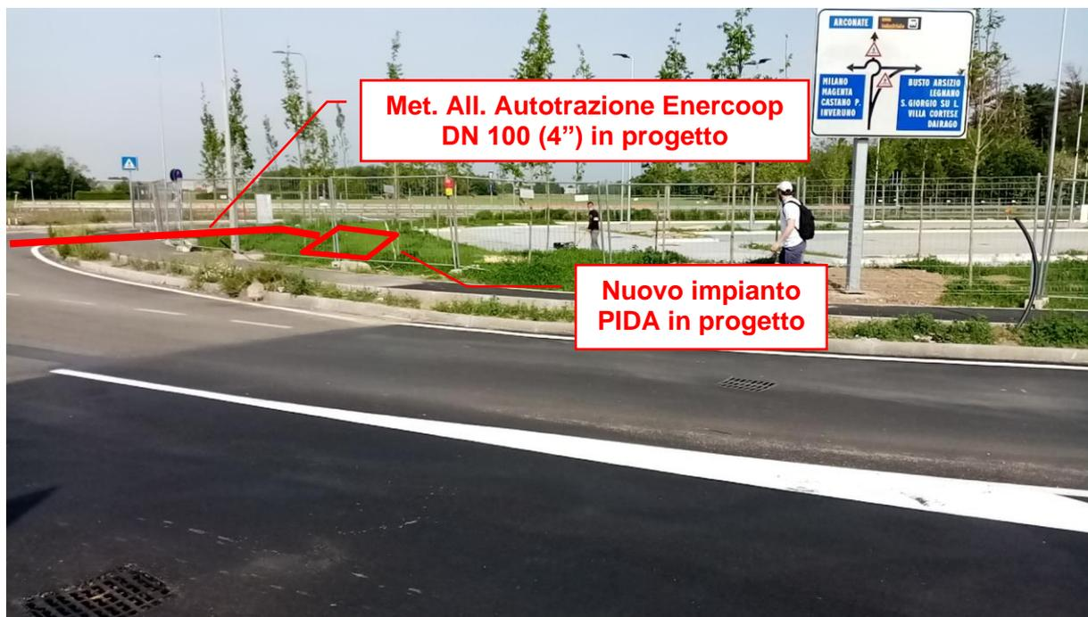
**Foto 11: Attraversamento Via Arconate e nuovo impianto PIDA**
