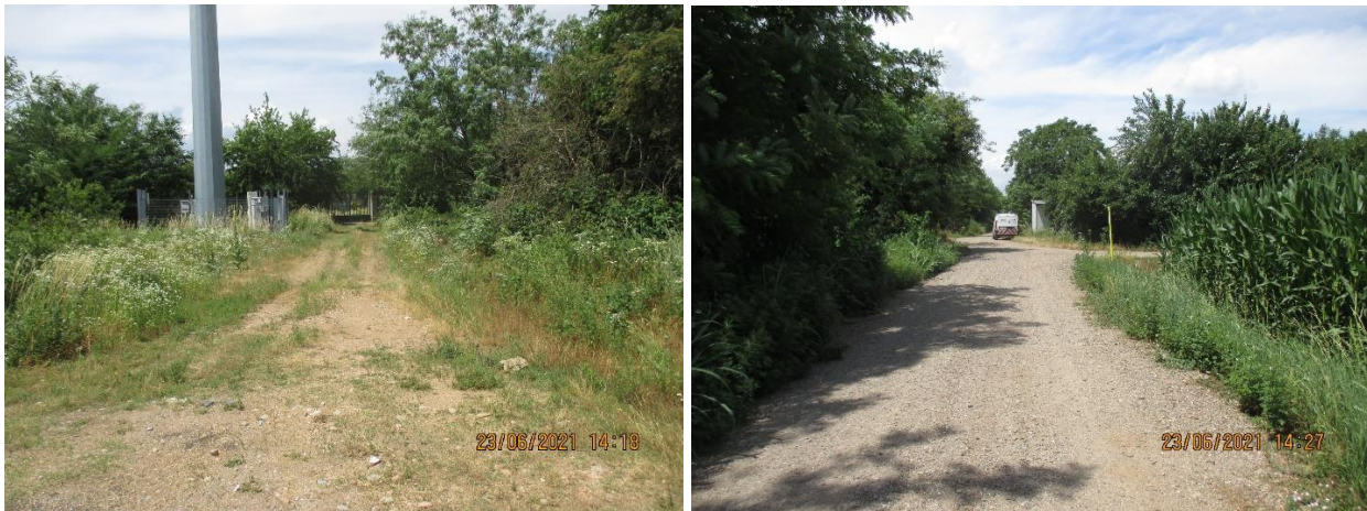
Figura 46 Area vasca e strada campestre lungo le camerette 1036-1315
