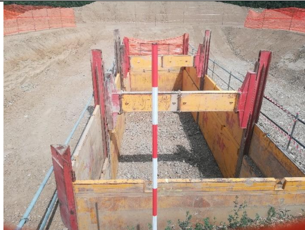
Figura 16. Esempio di blindaggio con guide e slittoni
