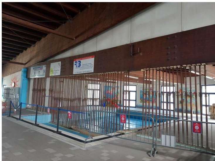
Vista delle travi puntellate
