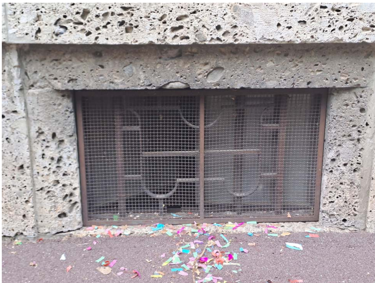
Il serramento in ferro
