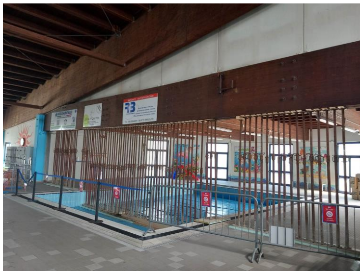
Vista delle travi puntellate
