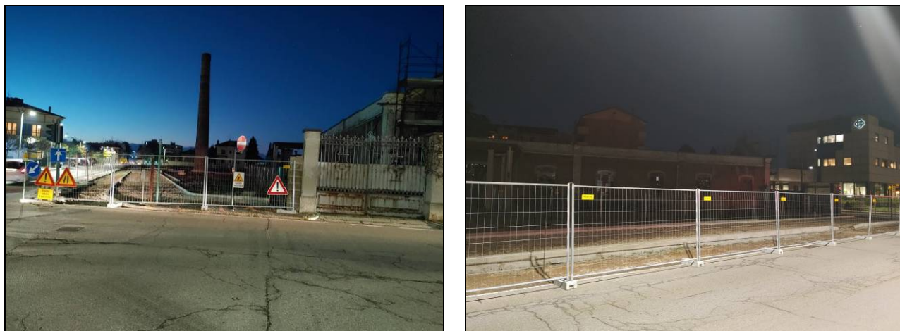
Figura 13 - Il cantiere presente al perimetro del sedime di intervento
