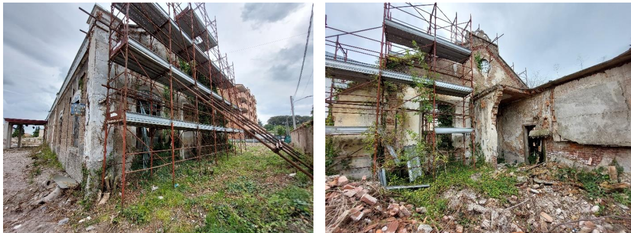
Fotografie dello stato di fatto della facciata su via Verdi, vista dall'esterno e dall'interno.
