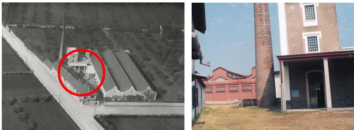
Fotografie storiche del portico. (A sinistra) in rosso si evidenzia la forma originale a L, (a destra) il portico in prossimità della centrale termica.
