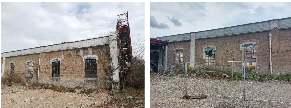
Fotografie dello stato di fatto della facciata su via Arconate.
