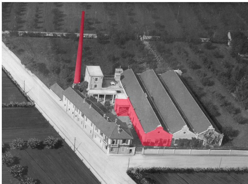
In rosso le porzioni del fabbricato che si sono conservate.
