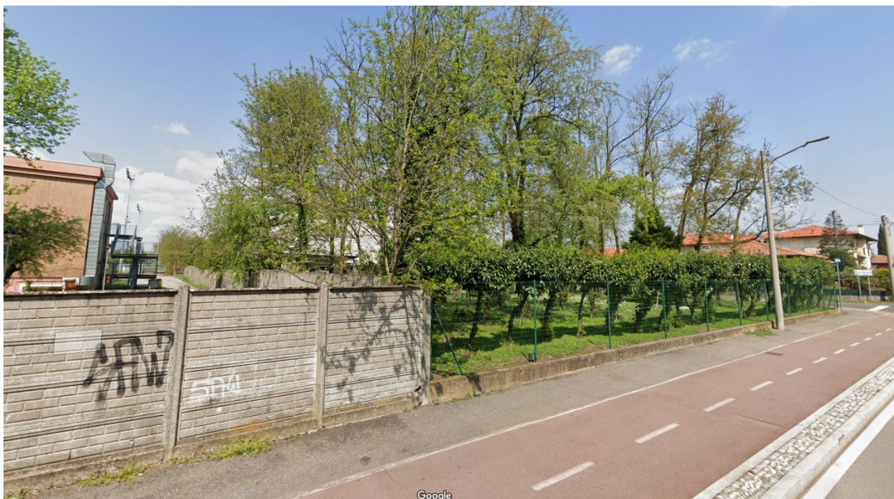
Fig.: vista dell'edificio scolastico (con scala di emergenza metallica) e dell'area di intervento, separati dalla recinzione prefabbricata.
