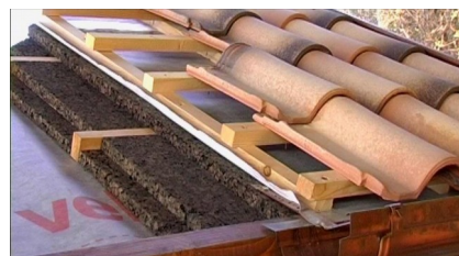
Isolamento sulla copertura
