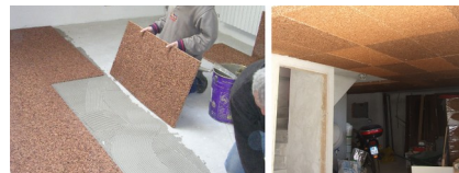
Isolamento a pavimento e a soffitto
